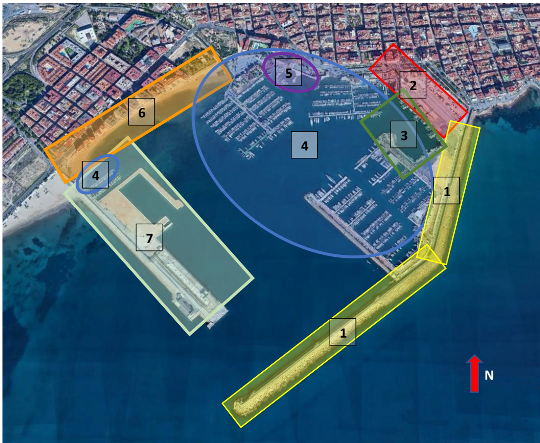
Figura.- Imagen vertical del puerto de Torrevieja con indicación de las unidades consideradas para el diagnóstico (Fuente: Elaboración propia sobre imagen de Google Earth)
